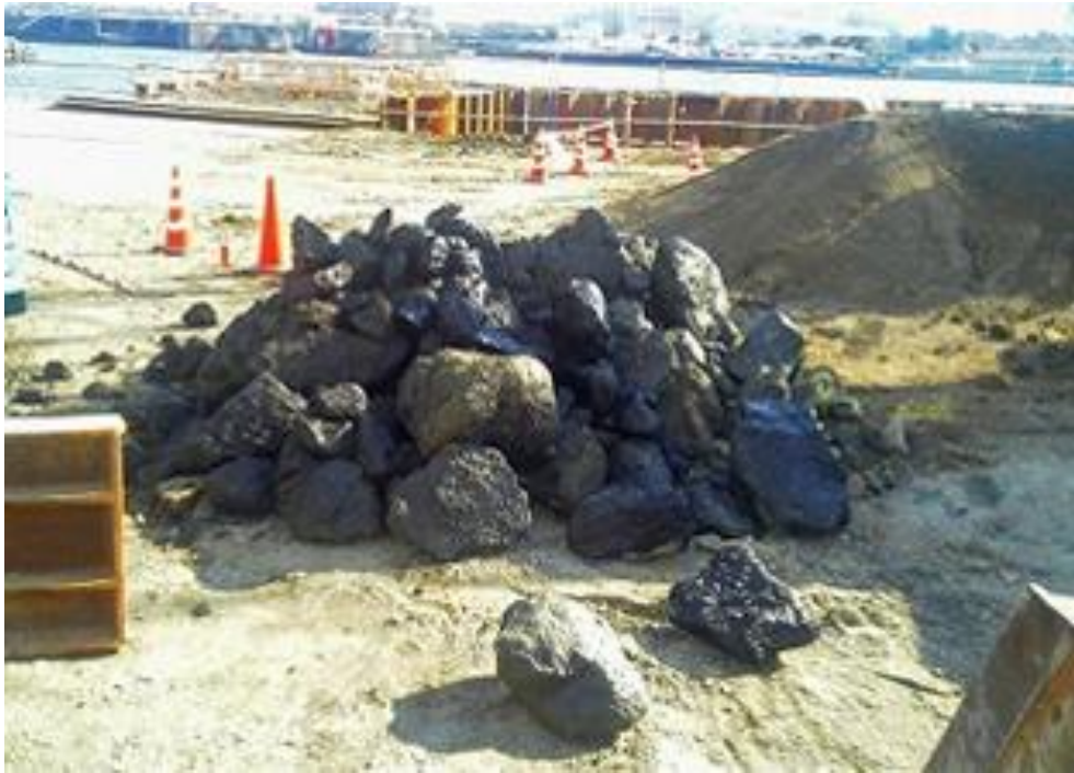
Underground obstacle removal situation(concrete) (地中障害物撤去状況 コンクリート)
