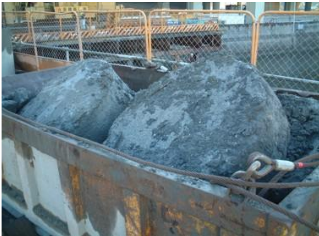
Removal of obstacles (concrete) (撤去コンクリートガラ)
