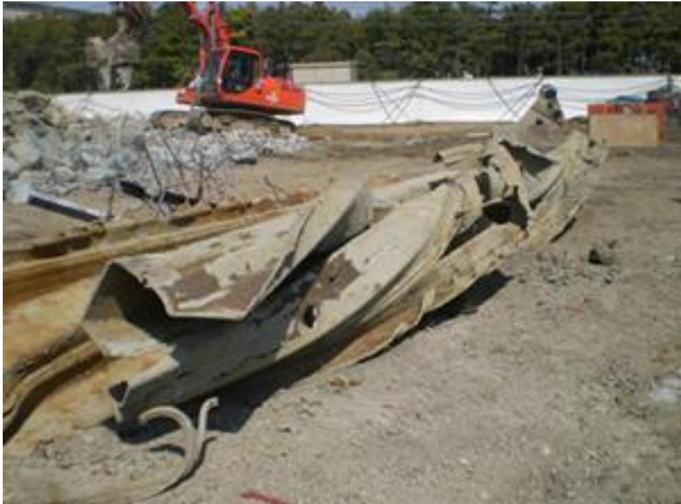
Underground obstacle removal situation(Sheet pile) (地中障害物撤去状況 シートパイル)
